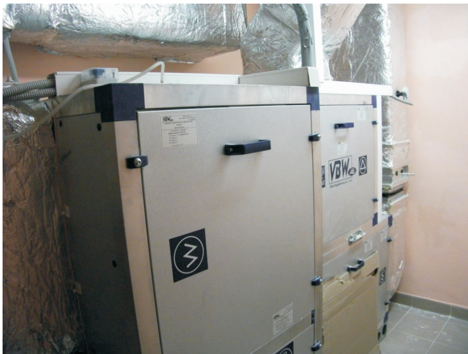
Nowoczesna centrala wentylacyjna umożliwiająca odzysk ciepła zainstalowana w Klubie „Opty” na Osiedlu Fabrycznym (ul. Techników 12) w ramach termomodernizacji budynku
