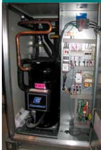
Fot./Fig: Pompa ciepła/ Heat pump
