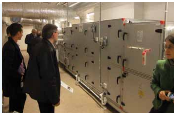
Fot./Fig: Centrala wentylacyjna/Central ventilation unit
