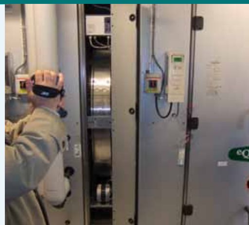
Fot./Fig: Obrotowy wymiennik ciepła/ Rotary heat exchanger
