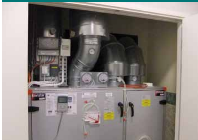
Fot./Fig: Nowa centrala wentylacyjna/ New central ventilation unit
