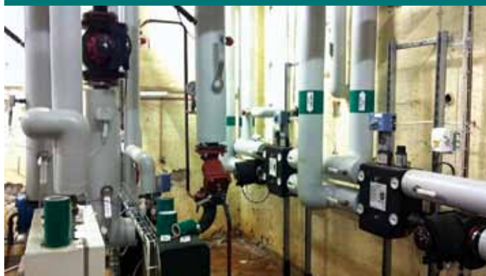
Fot./Fig: Dystrybucja ciepła z urządzeniami pomiarowymi/ Heat-distribution with measuring devices
