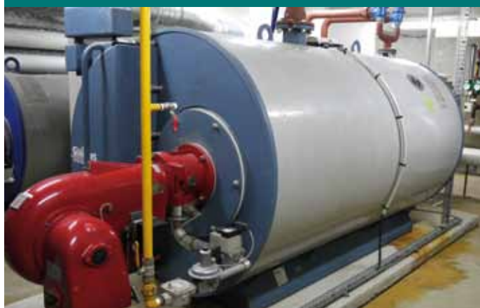
Fot./Fig: Kocioł gazowy z palnikiem/ Gas boilers with forced draught burner
