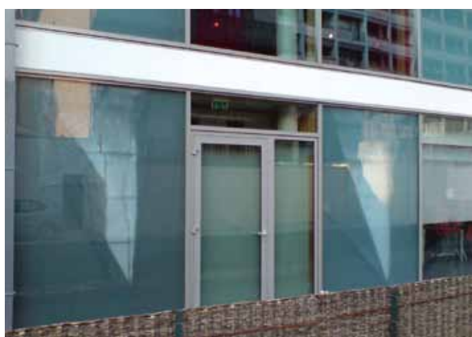
Fot./Fig: Termicznie słaba rama drzwi zewnętrznych/ Thermally poor frame of an exterior door
