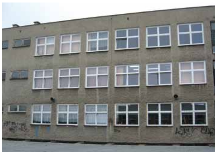
Fot./Fig: Mostki termiczne z powodu wnęk grzejnikowych/Thermal bridges due to radiator niches
