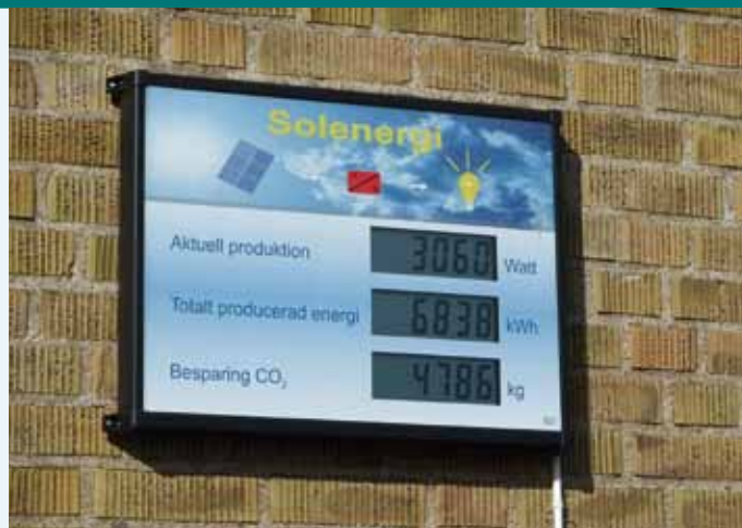
Fot./Fig: Wyświetlacz cyfrowy systemu fotowoltaicznego/ Digital display revenue of the photovoltaic system
