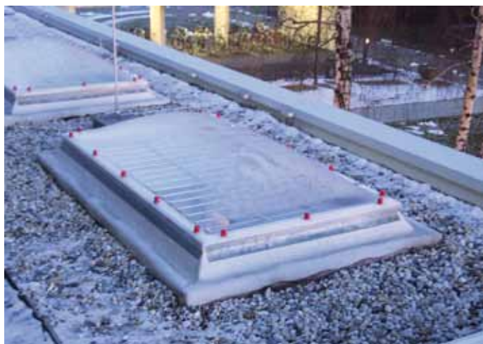
Fot./Fig: Mostki cieplne w miejscu połączenia konstrukcji dachu ze świetlikami/Thermal bridges in the connection point of the flat roof and light dome
