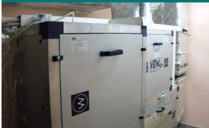
Fot./Fig: Nowa jednostka wentylacyjna z odzyskiem ciepła/ New ventilation unit with heat recovery
