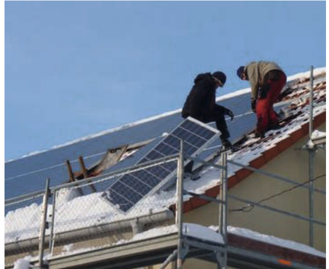
Abbildung 15: Montage der Photovoltaikmodule
