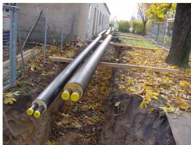
Abbildung 4: Verlegung von Fernwärmeleitungen
