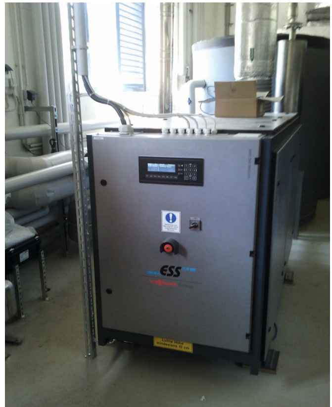
Abbildung 26: Blockheizkraftwerk mit Pufferspeicher im Hintergrund
