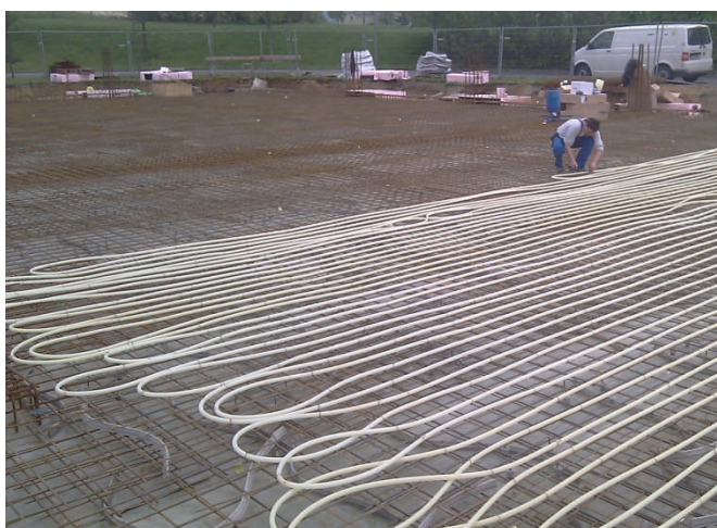
Abbildung 22: Betonkernaktivierung
