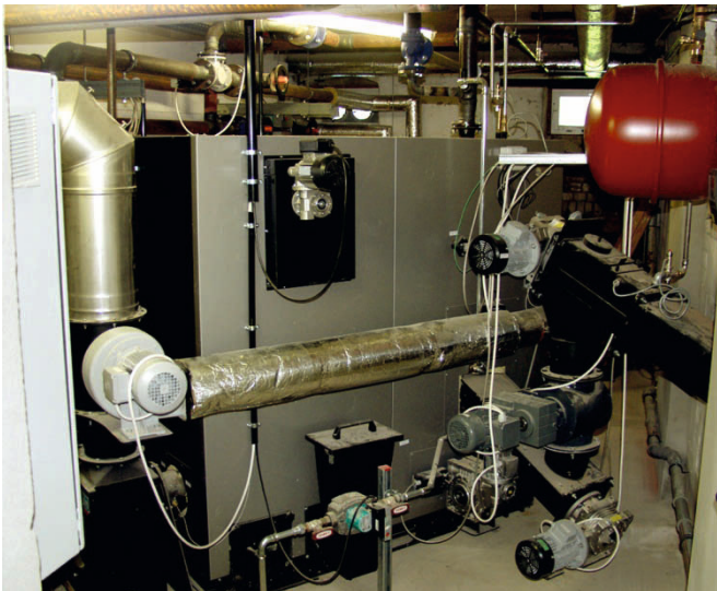
Abbildung 7: Pelletheizung im Keller der Grundschule Großharthau
