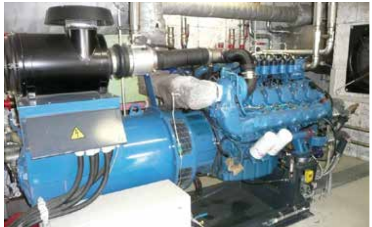
Abb. 22: BHKW einer Biogasanlage
