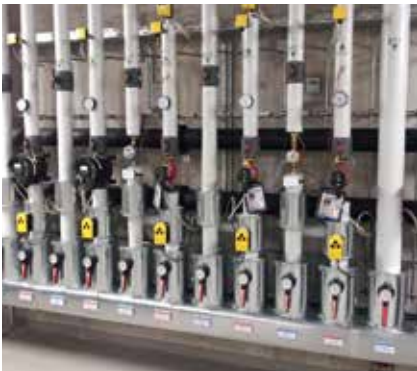
Abb. 19: Druck- und Temperatur-Messarmaturen an einen neuen Heizungsverteiler
