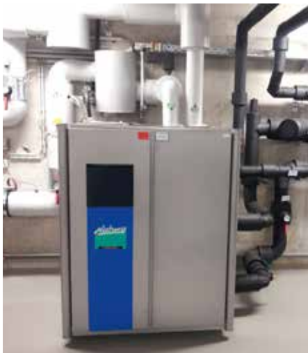
Abb. 13: Wasser-Wasser Wärmepumpe
