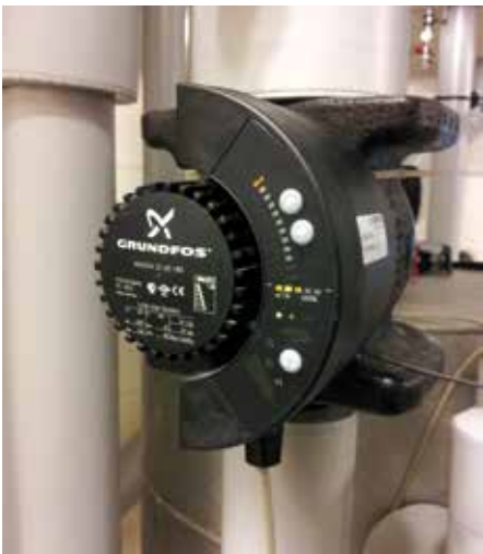
Abb. 15: Hocheffiziente Heizungsumwälzpumpe
