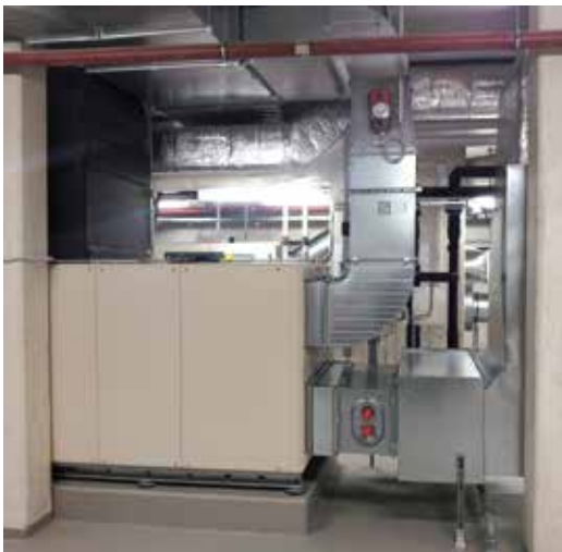
Abb. 14: Lüftungsanlage mit Wärmerückgewinnung
