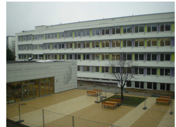
Passivhauschule – Wilhelm-Ostwald-Gymnasium Leipzig
